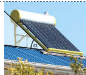
Photovoltaikanlage zur Erwärmung von Wasser mit Sonnenenergie
