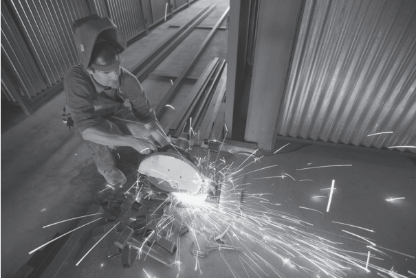
1. Ein Arbeiter an der Schleifmaschine
