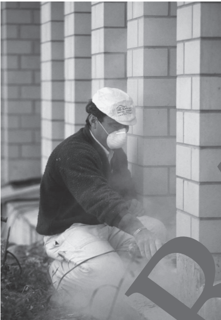
3. Bauarbeiter beim Schleifen
