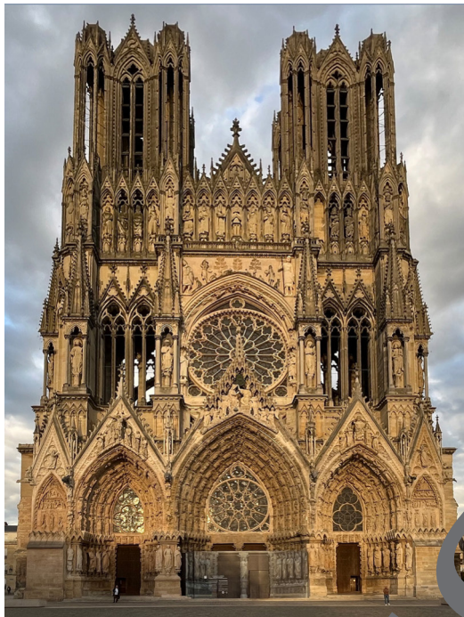
Die Doppelturmfassade der Kathedrale an der Westseite mit den drei großen Trichterportalen und den großen Fensterrosen
