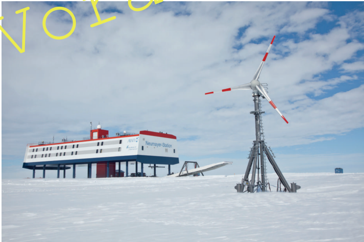
Die Forschungsstation „Neumayer III“. Eine 30-Kilowatt-Windkraftanlage trägt zur umweltfreundlichen Energieversorgung der Station bei.
